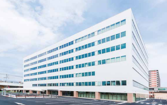
事務所の建物外観
